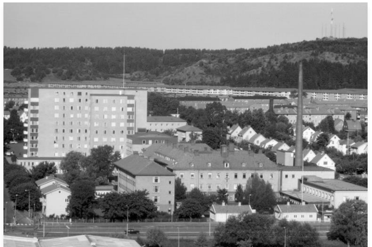
Bild på K-huset från 1973. Huset byggdes 1968. I förgrunden syns de äldre sjukhusbyggnaderna
